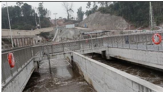
磁混凝沉淀池
