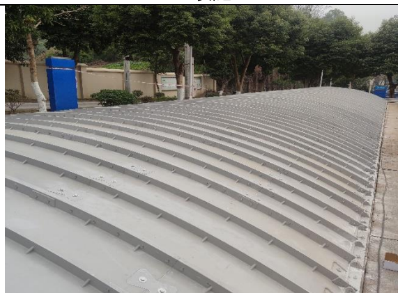
一、二期及提标改造工程的产臭构筑物加盖
